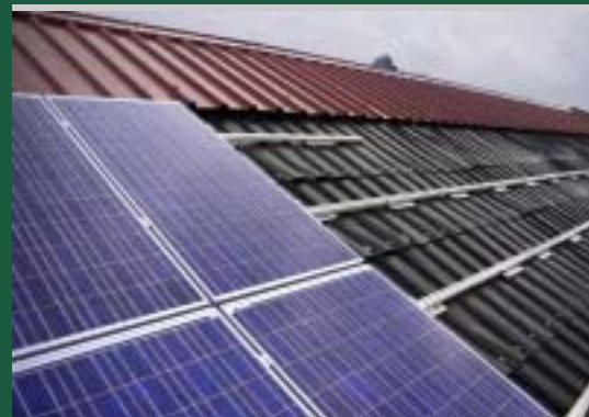
180 m 2 de panneaux et de membranes photovoltaïques en cours d'installation
