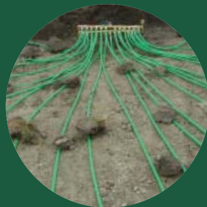
L'installation du plateau absorbant d'une surface d'environ 450 m 2
