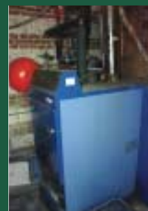
Un silo de céréales relié à la chaudière permet d'être autonome en chauffage.
